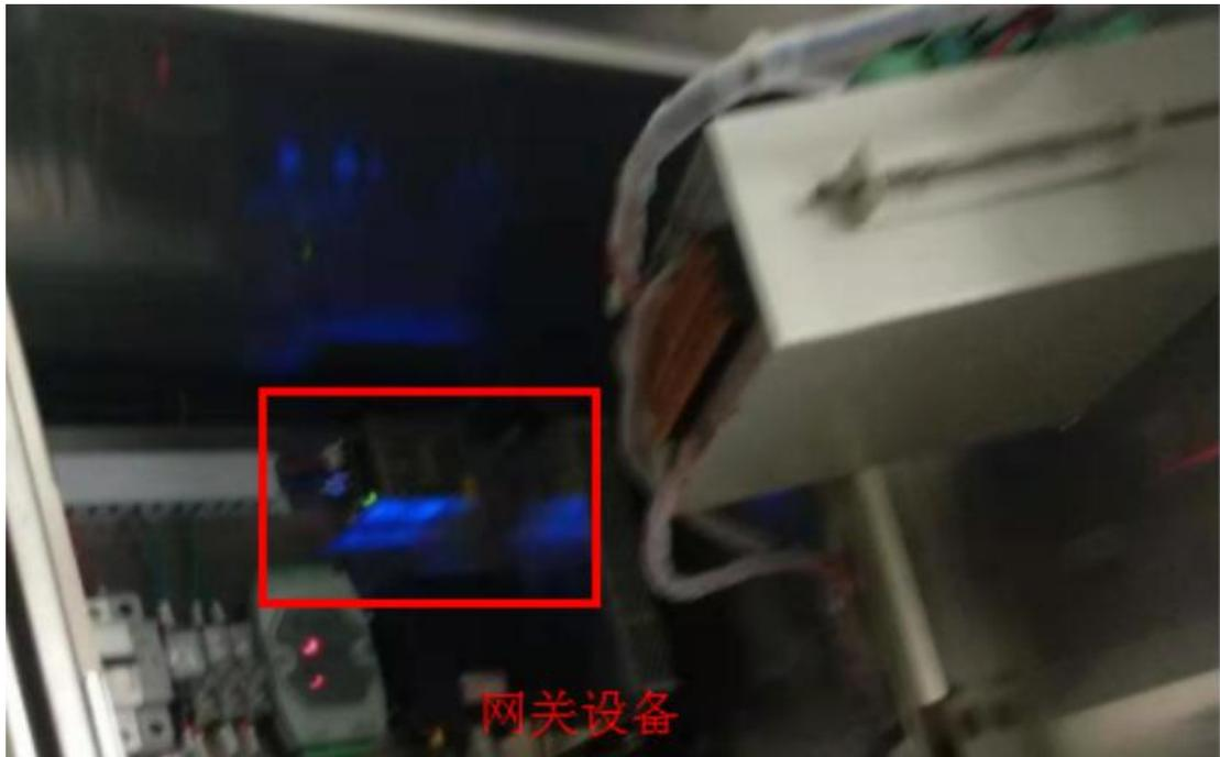
打开气表后，可在 485 接口接上网关，已经对应的控制线路
